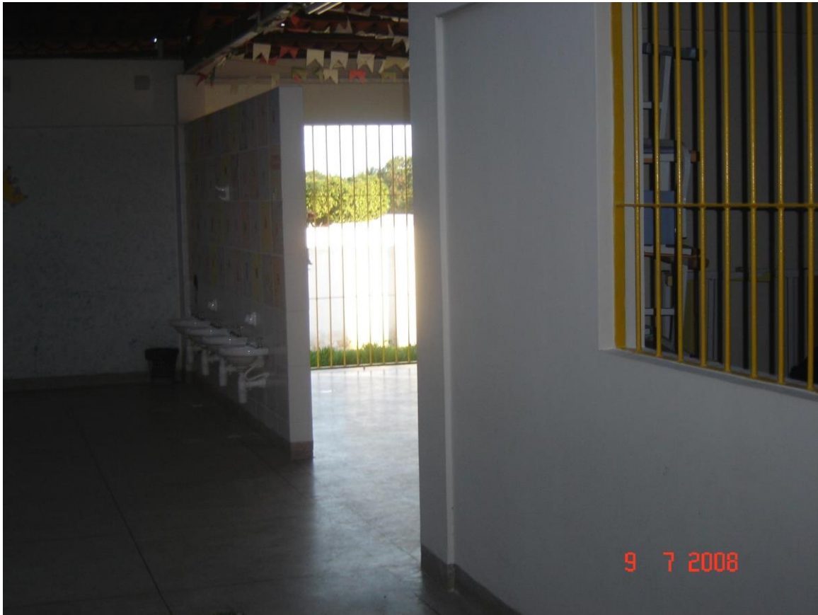
Foto 24. Sala dos especialistas, refeitório e pátio coberto
