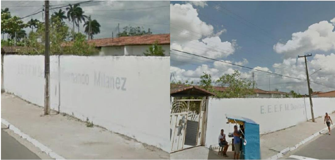
Figura 2 – Escola Estadual Dep. Fernando Milanez. Local de aplicação deste trabalho.
