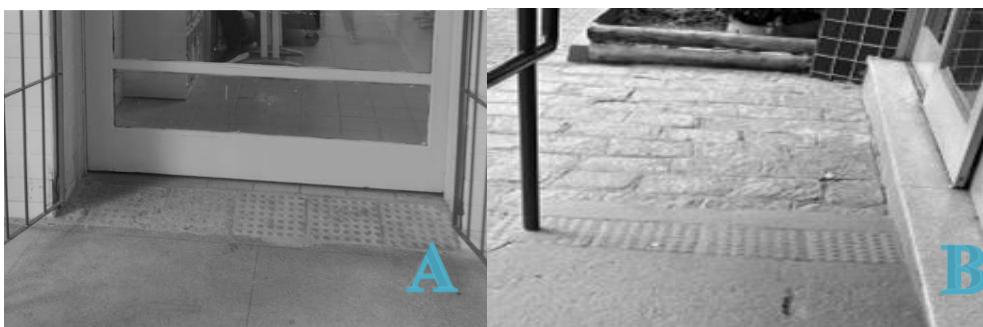
FIGURA 02: PISO TÁTIL NA ENTRADA DA BIBLIOTECA (A) E DA RAMPA DE ACESSO AO HALL (B)
