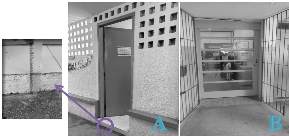
Figura 08 - Portas utilizadas nas entradas das salas de aula e biblioteca
