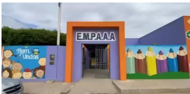
FIGURA 1: FACHADA DA ESCOLA MUNICIPAL PROFESSOR ARNALDO ARSÊNIO DE AZEVEDO, MUNICÍPIO DE PARELHAS/RN, 2024.
